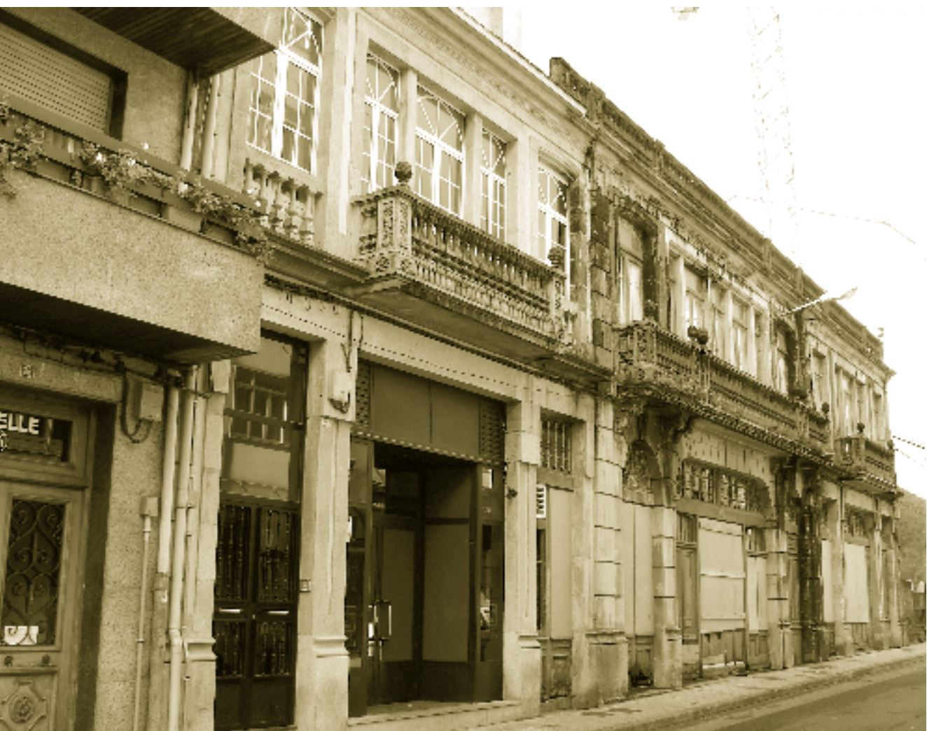
Instituto da Estrada (1931), abandonado e en parte reformado, 2005) (Foto CGP)
